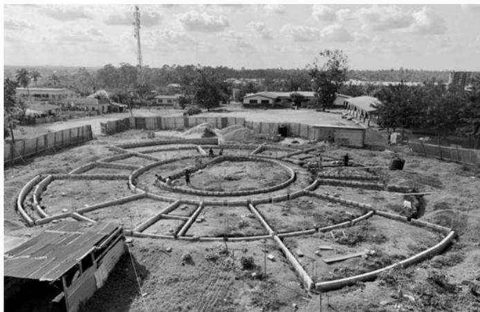
meinde (im Rahmen sogenannter „Community Work Days“) wurde das Grundstück geräumt, das Bauvorhaben abgesteckt, das Fundament ausgehoben, und der Beton für das Fundament gegossen.
